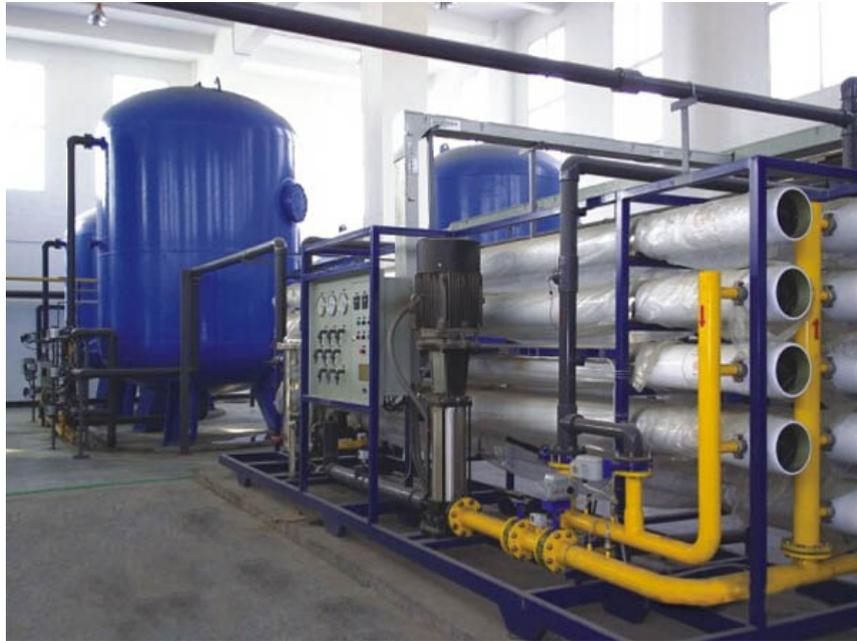
反渗透设备使用的注意事项以反渗透膜为主要的反渗透设备，在日常启停时，要了解相关注意事项，规范进行操作，错误操作一定会对膜性能产生损坏。，小编就给大家介绍下反渗透设备的启动及停止时的注意事项吧。因为，每一次的启动与停止都会带来流量与压力的变化，对反渗透膜产生机械应力，我们需要尽可能的降低系统启动与停止的频率，正常的启动与停止也要平稳的进行。流量和压力的上升下降要缓慢进行，时间控制在30-60秒，系统所需的时间也要相对应延长。设备的启动和停止可由PLC实现自动控制，但要定期检查相应电气设备的运行状态。反渗透膜是相对比较脆弱的元件，所以我们在使用时对于反渗透膜的启动与停止一定要多加的注意，按照使用规则，正确的使用膜产品，平时的各种事项也要多加注意，还要经常的进行维护与保养，使反渗透膜的使用时间更长久。
